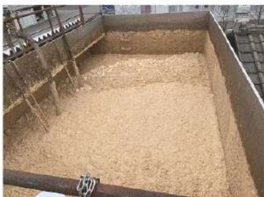
導入前の曝気槽
