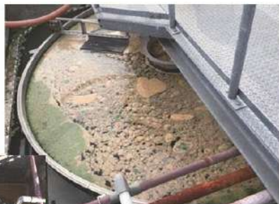
導入前の沈殿槽
