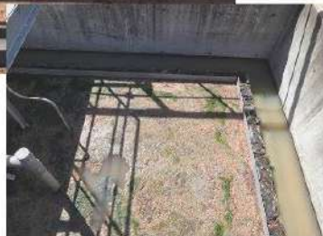
導入前の沈殿槽
