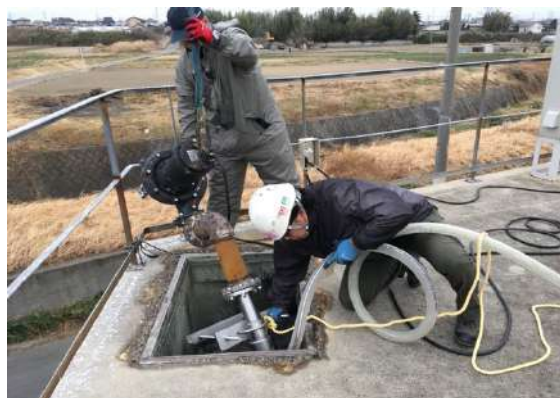
調整槽に設置
