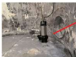
内部に設置されたYJマイクロ・ ナノバブル発生装置
